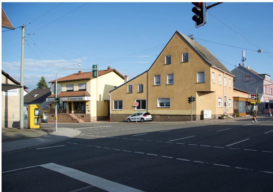
Blick von Südosten über die Kreuzung Saarbrücker Straße - Walpershofer Straße auf das Plangebiet (links)
